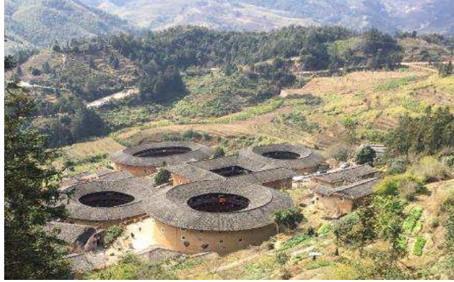
Fig. 1. Photo of the Tianluokeng Tulou cluster
