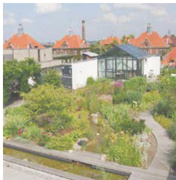
Fig. 02.02.05 Intensive green roof, Wiegmann-Klinik Berlin Germany . Source: Bundesverband GebäudeGrün e. V. (BuGG)
