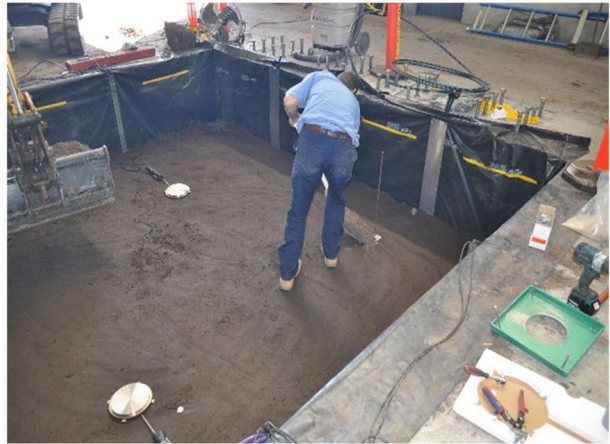
40 (d) Pressure cells on top of subgrade
