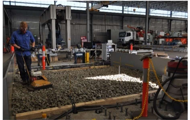
(d) Compaction of ballast layer
