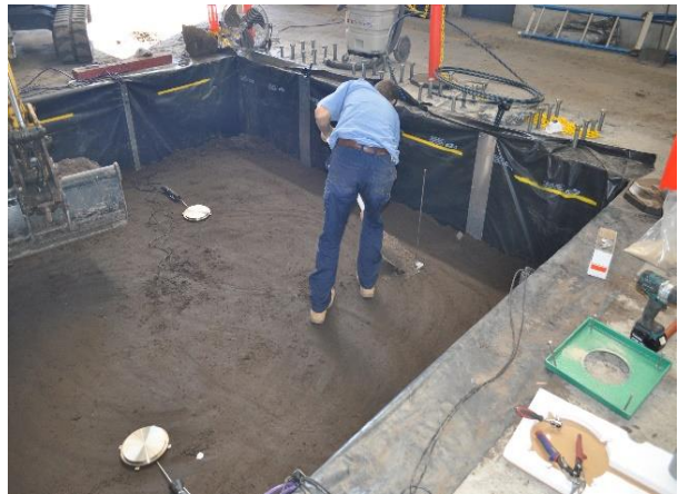
(d) Pressure cells on top of subgrade
