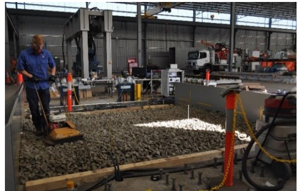
(d) Compaction of ballast layer
