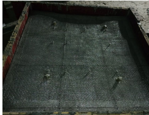
(d) Installation of SWM and steel bar
