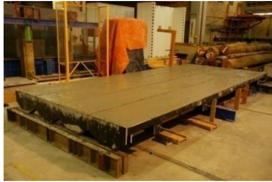
(b) TCC beams after concrete pour
