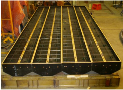
(a) TCC beams before concrete pour
